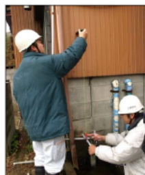
(住宅の傾斜の計測)
